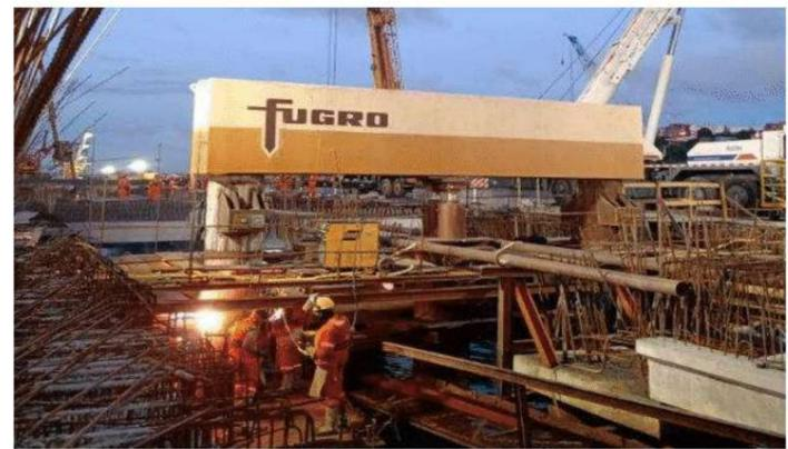
Figura 5: Viga posicionada para execução do ensaio de prova de carga estática instrumentada
