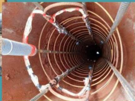
Figura 3: *strain-gages* resistivos instalados junto à armadura da estaca
