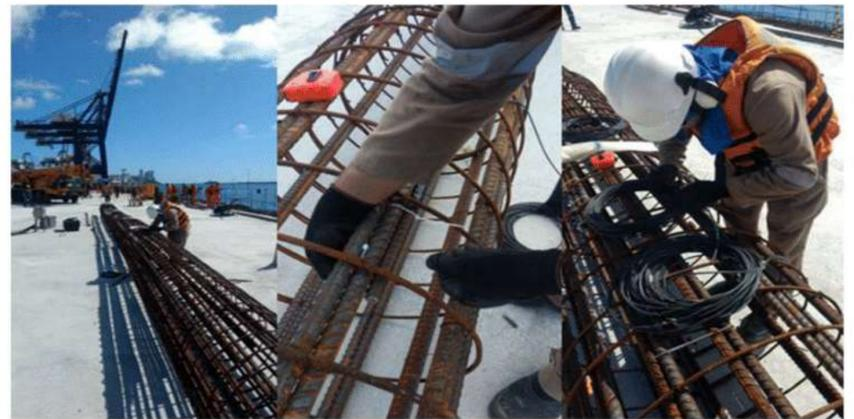
Figura 4: Armadura com *strain-gage* de corda vibrante instalados no momento da colocação da armadura que compõe o elemento estrutural
